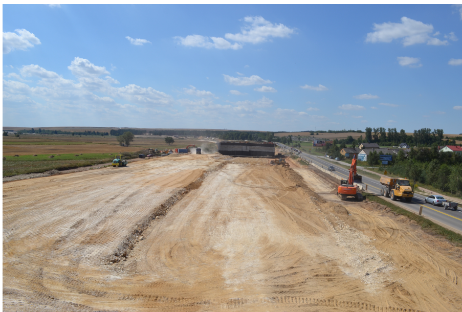
Fot. 2 Droga ekspresowa S7 na odc. Chęciny-Jędrzejów w budowie
