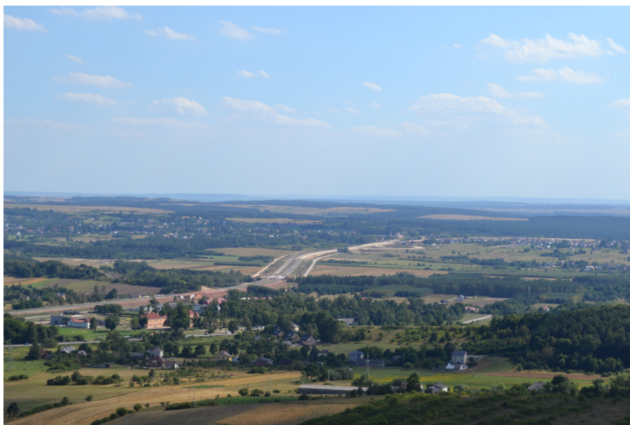
Fot. 6 Widok z wieży Zamku na budowę drogi ekspresowej S7 – w kierunku Krakowa
