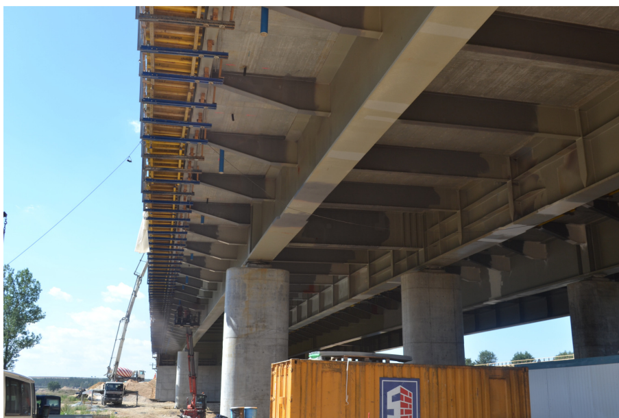
Fot. 3 Obiekt mostowy nad rz. Nidą w ciągu drogi ekspresowej S7
