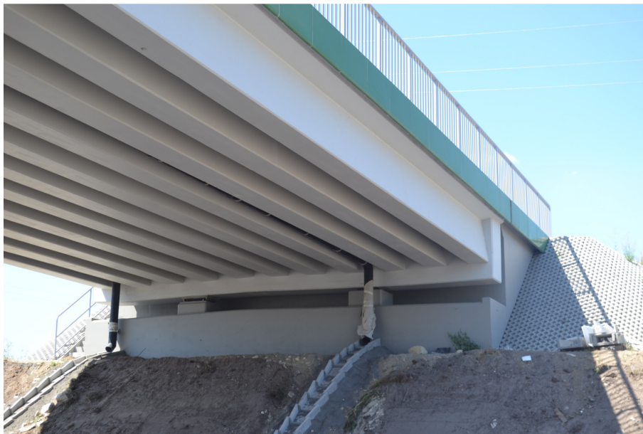
Fot. 4 Jeden z obiektów mostowych na trasie nowobudowanej drogi ekspresowej S7 na odc. Jędrzejów granica woj. świętokrzyskiego
