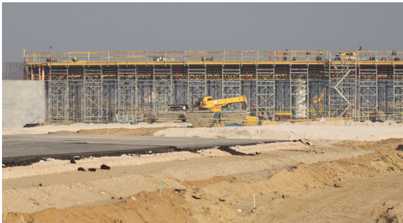
Budowa Autostrady A2, 2011 r., fot. Rafał Bałdys, wykonawca: EUROVIA
