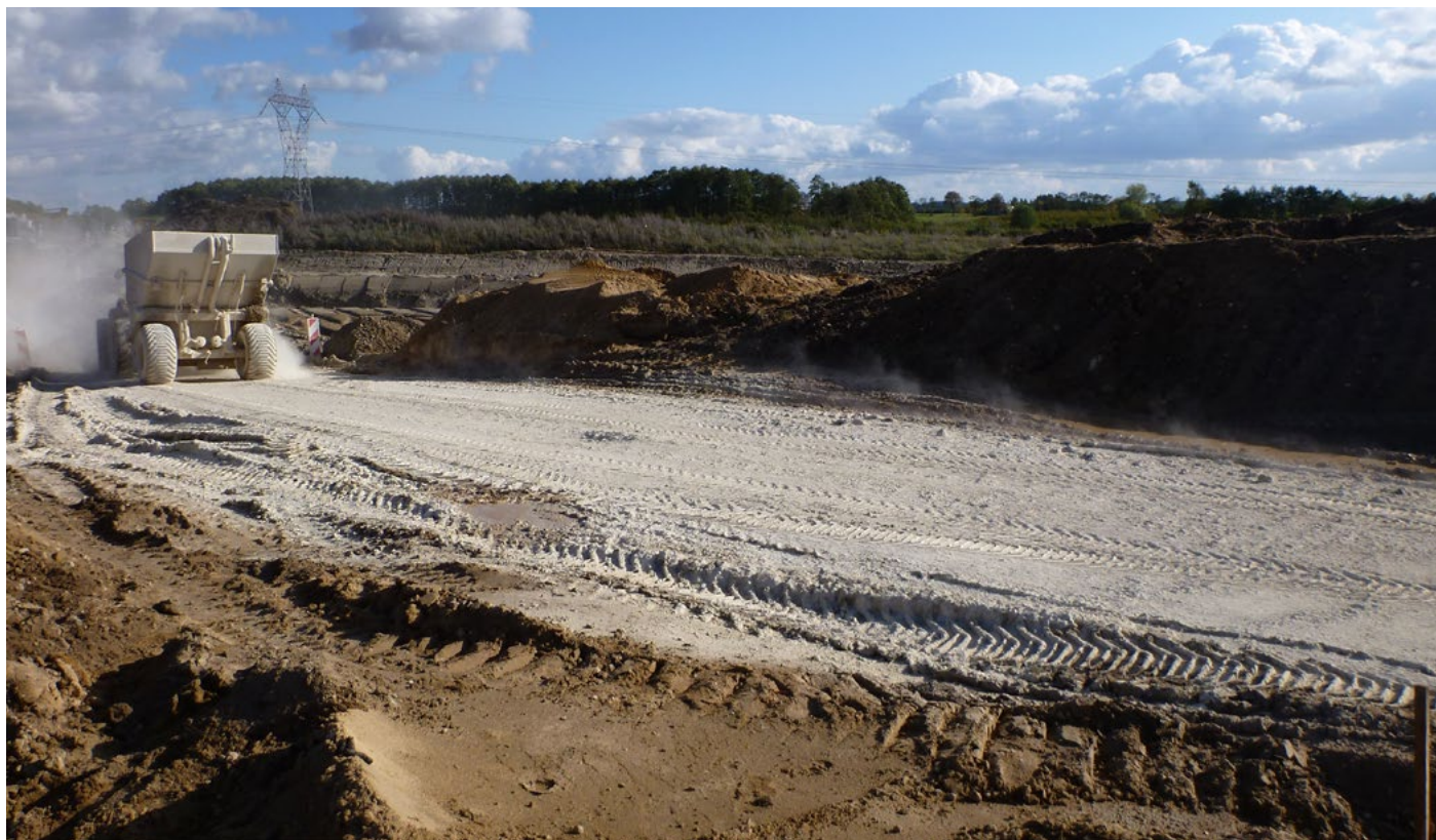
Budowa Autostrady A2, 2011 r., fot. Michał Siejda, wykonawca: EUROVIA
