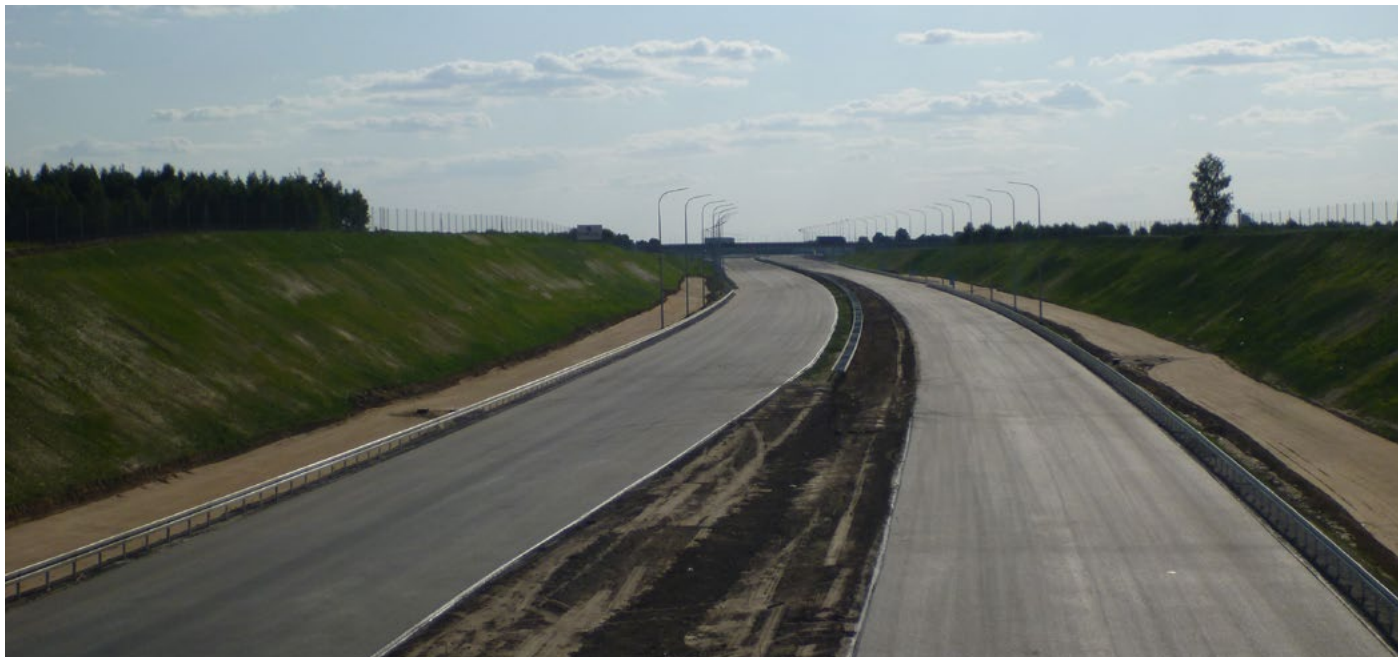
Budowa Autostrady A2, 2011 r., fot. Michał Siejda, wykonawca: EUROVIA
