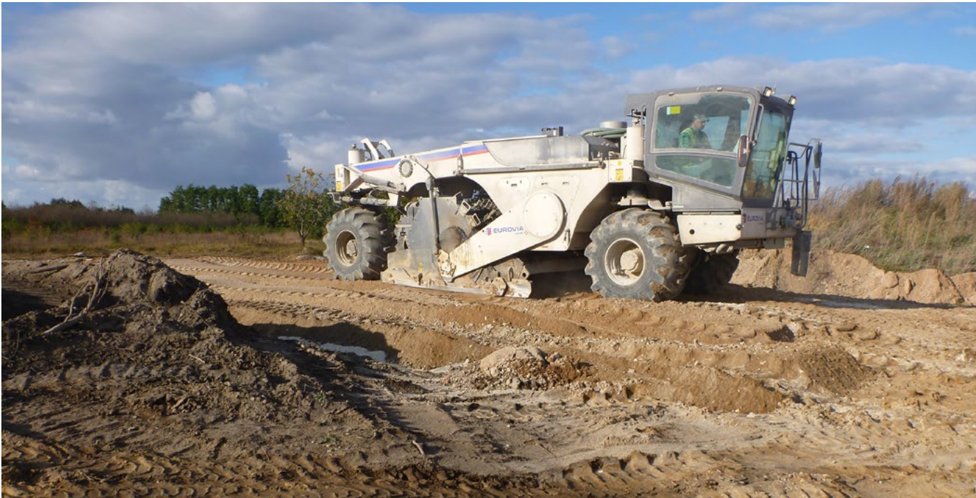
Budowa Autostrady A2, 2011 r., fot. Michał Siejda, wykonawca: EUROVIA
