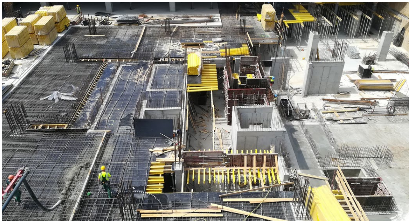
Budowa hotelu MOXY w Pyrzowicach, fot. Grzegorz Dukata
