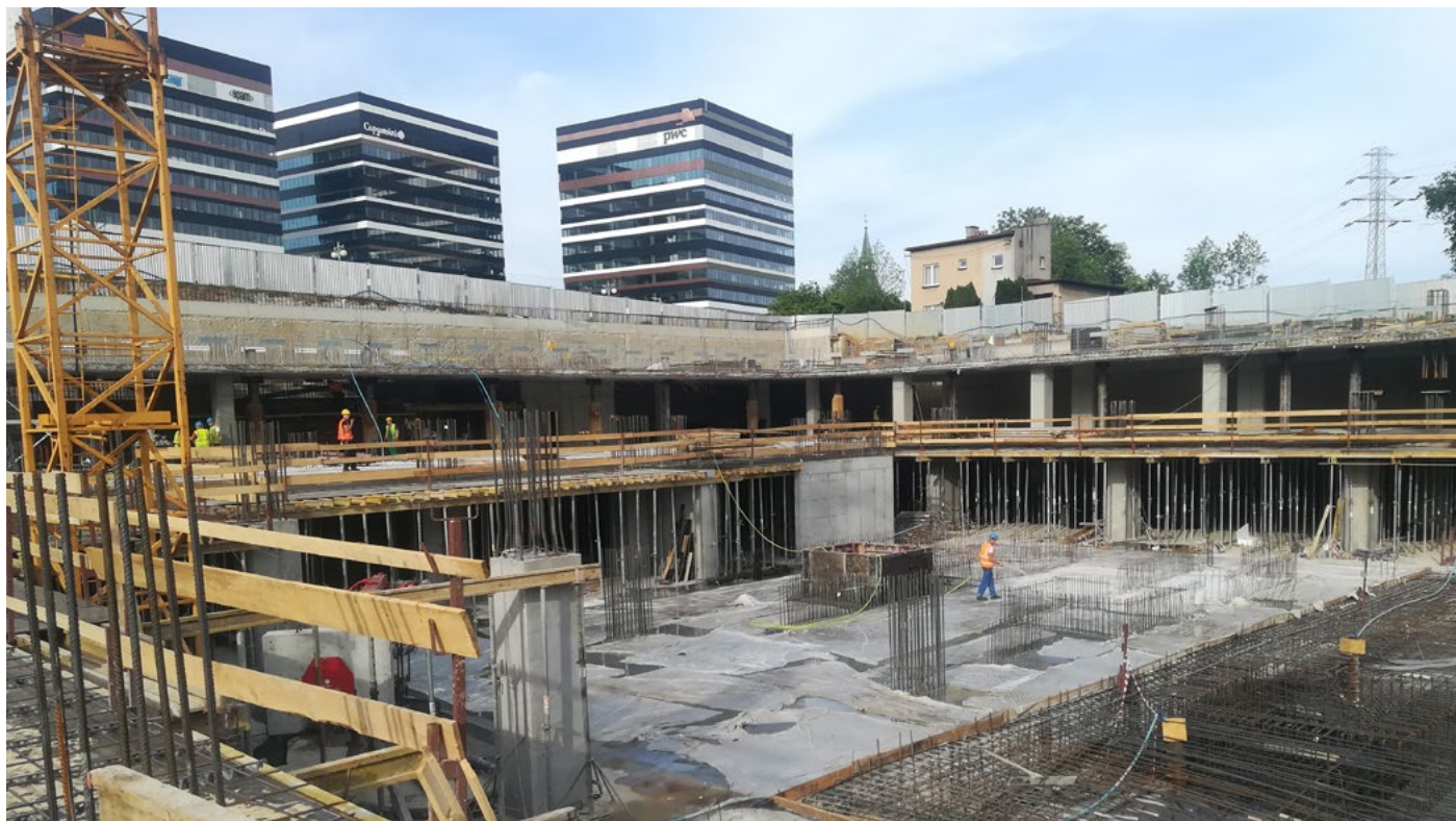
Budowa biurowca Silesia 4 Business w Katowicach, fot. Grzegorz Dukata
