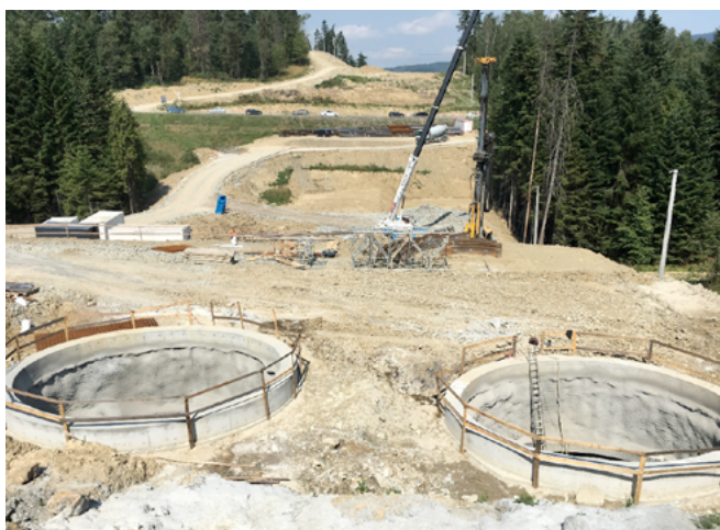
Fot. 2 Studnie z wykonaną na ścianach opinką torkretową
