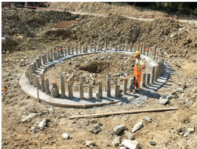
Fot. 1 Wykonana elipsa z mikropali, głowice przygotowane do skucia i ścięcia
