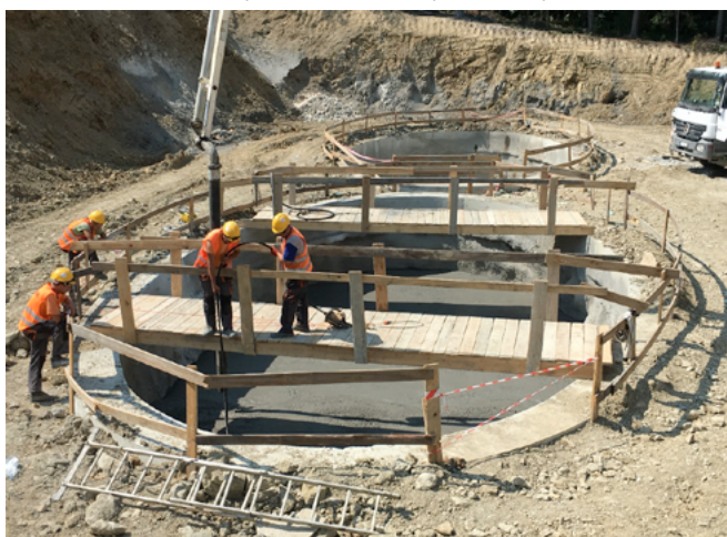
Fot. 3 Wypełnienie gotowej studni betonem
