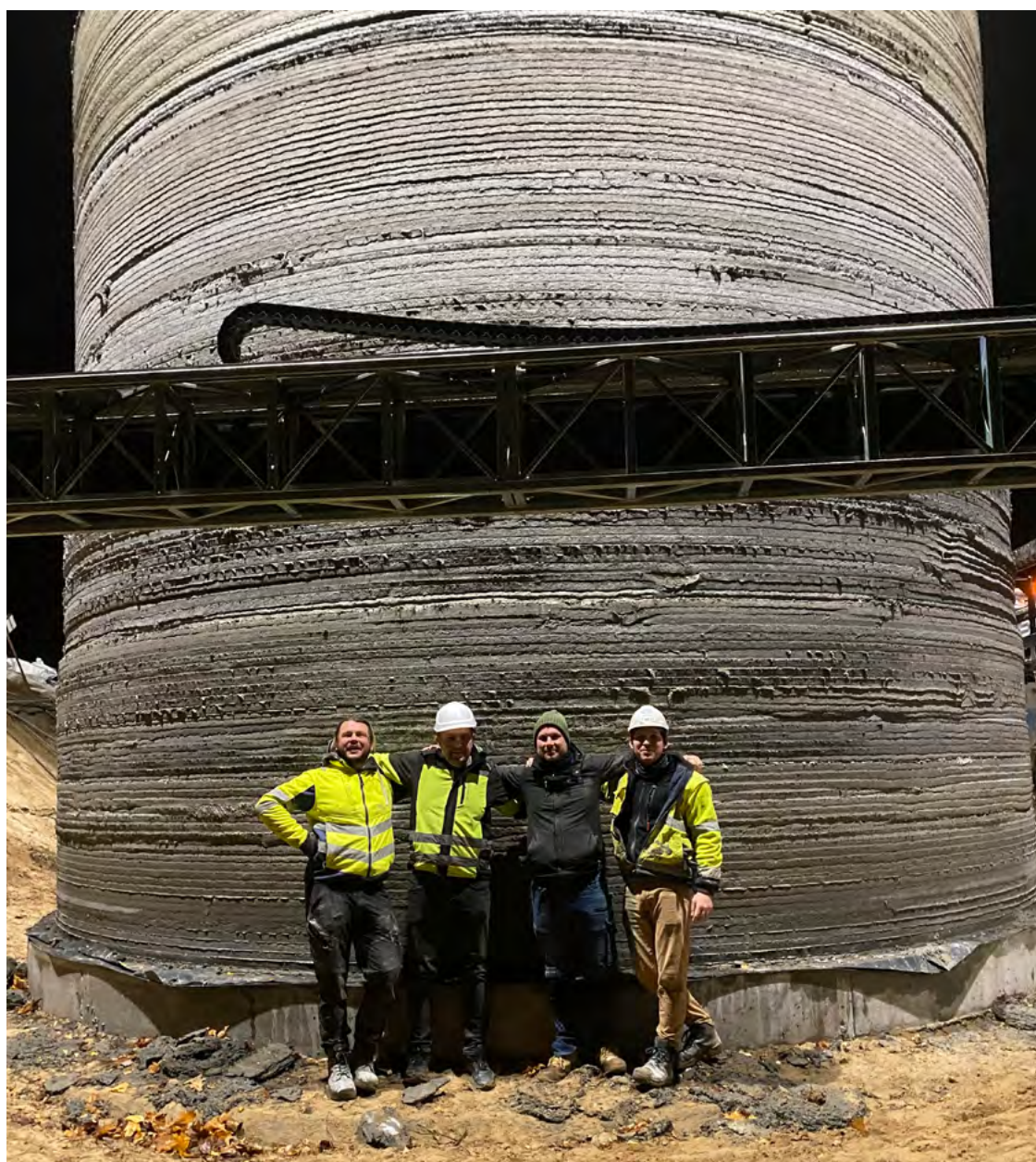
Część zespołu realizacji wydruku na tle ukończonego zbiornika: Piotr Czarnecki (Ekowod), Michał Stysz (COBOD International), Marcin Mikulewicz (Globtank), Rafał Latawiec (Holcim)
