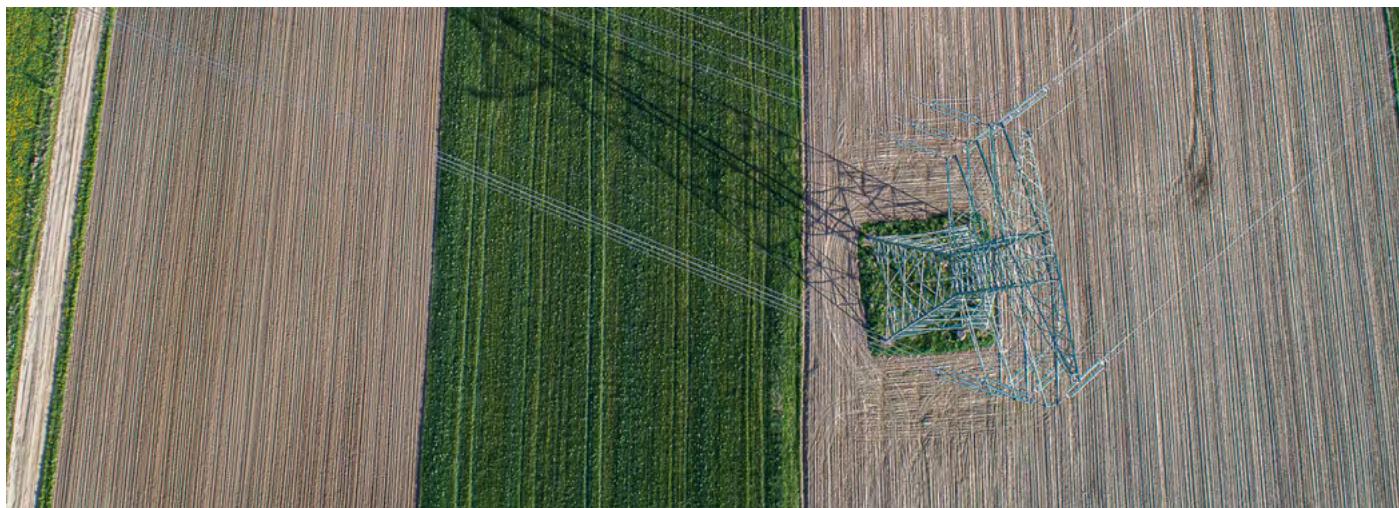
fot. Polskie Sieci Elektroenergetyczne S.A., inwestycja: Stacja Elk Bis, wykonawca: ELFEKO S.A.
