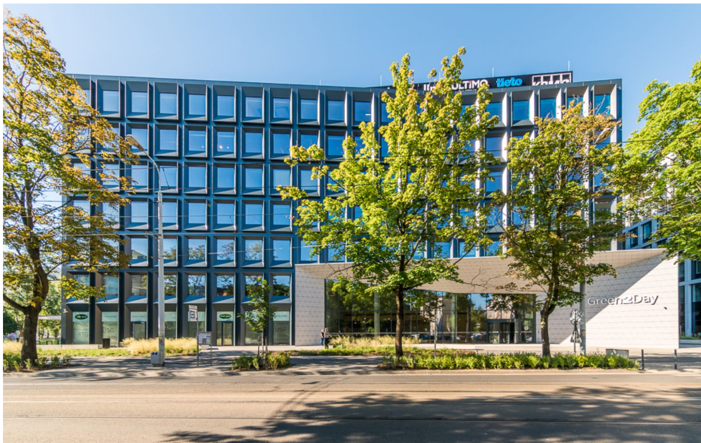
Fot.1. Elewacja frontowa budynku biurowego Green2Day we Wrocławiu
